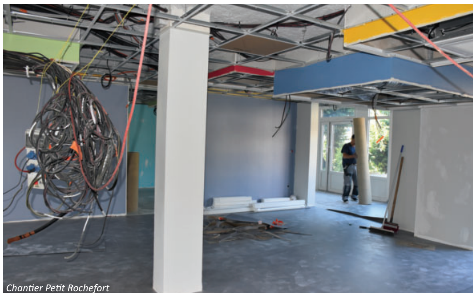
Chantier Petit Rochefort
