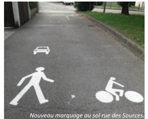
Nouveau marquage au sol rue des Sources.
